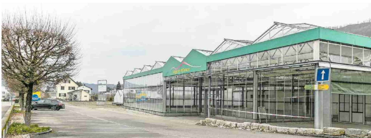
Die Gewächshäuser neben dem Blumenladen «Lägere Blueme» sollen im Mai oder Juni abgerissen werden.
